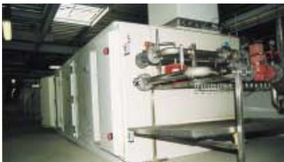
Photo 3 - Caisson de traitement de l'air en galerie technique
