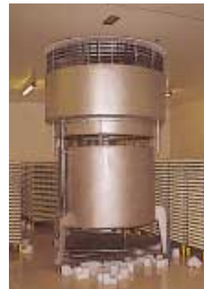
Conditionneur d'air sur pieds à soufflage direct par plénum incorporé "Compagnie des Fromages, Ducey (50)"
