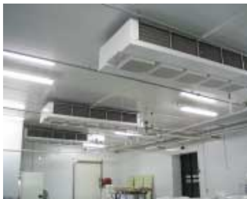
Photo 1 - Evaporateurs double-flux
